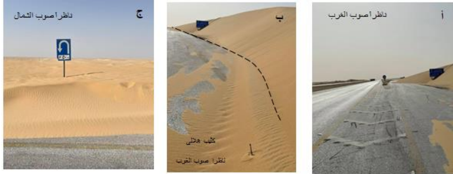
لوحة (٢٦) ردم الكثبان الرملية لإرشادات الطريق بقطاع الطريق الثاني.
