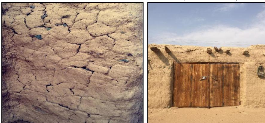
شكل رقم (٢٠) التشققات الطينية في جدران وأسقف سوق الجابرية بعد ترميمها نتيجةً للجفاف
