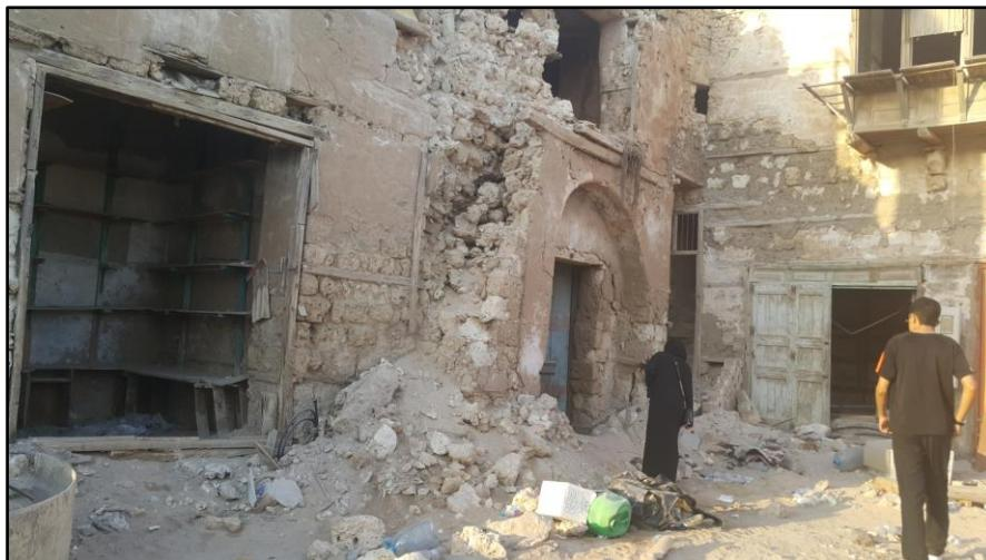
شكل رقم (٢٢) تفكك الصخور وانهيار المباني بسبب نمو البلورات الملحية بالمنطقة التاريخية بينبع البحر
